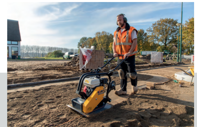
Präzises Arbeiten durch die speziell geformte Grundplatte
